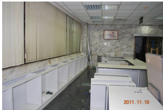
圖 4-24 服務台資料矮櫃組裝施工。
