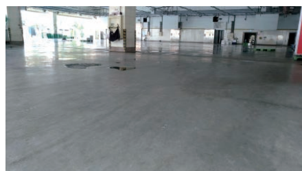
輔導彰化埔心魚市場改為 RC 地坪，改善積水不平整情形
