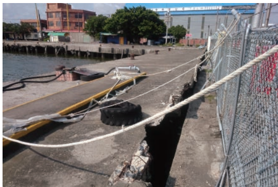
興達漁港碼頭鋪面改善——原鋪面基礎結構鏽蝕損壞
