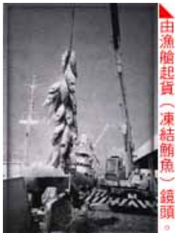
▲於清水魚市場使用起重機及配合魚類輸送機自動起卸魚貨。
