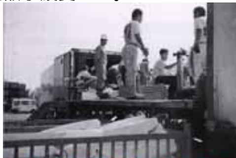
▲卸魚前搭建與冷凍車等高之工作平台避免二次搬運。
