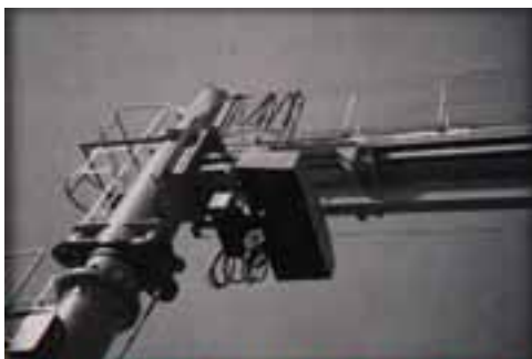
▲新長崎浮動棧橋具備伸縮性的大型自動起重機。
