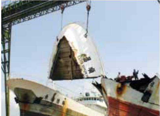
↑減船漁船之船體拆解情況。
