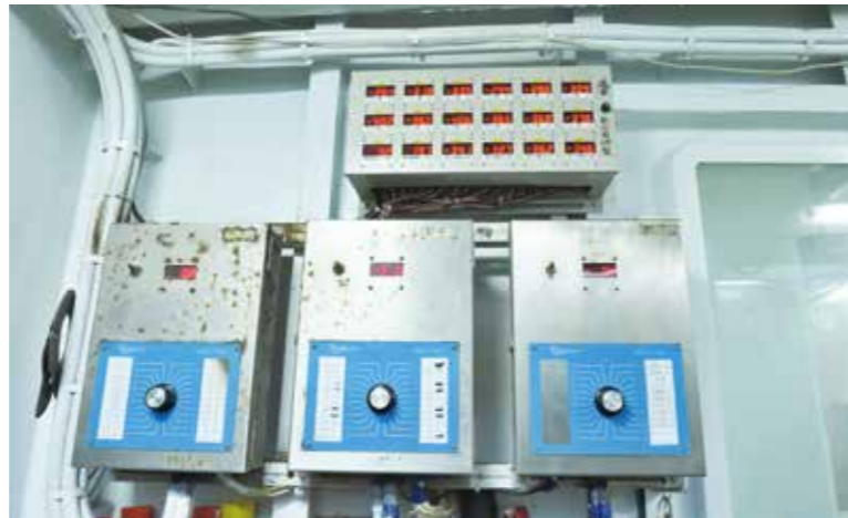
船艙內每個凍庫的溫度記錄器。
