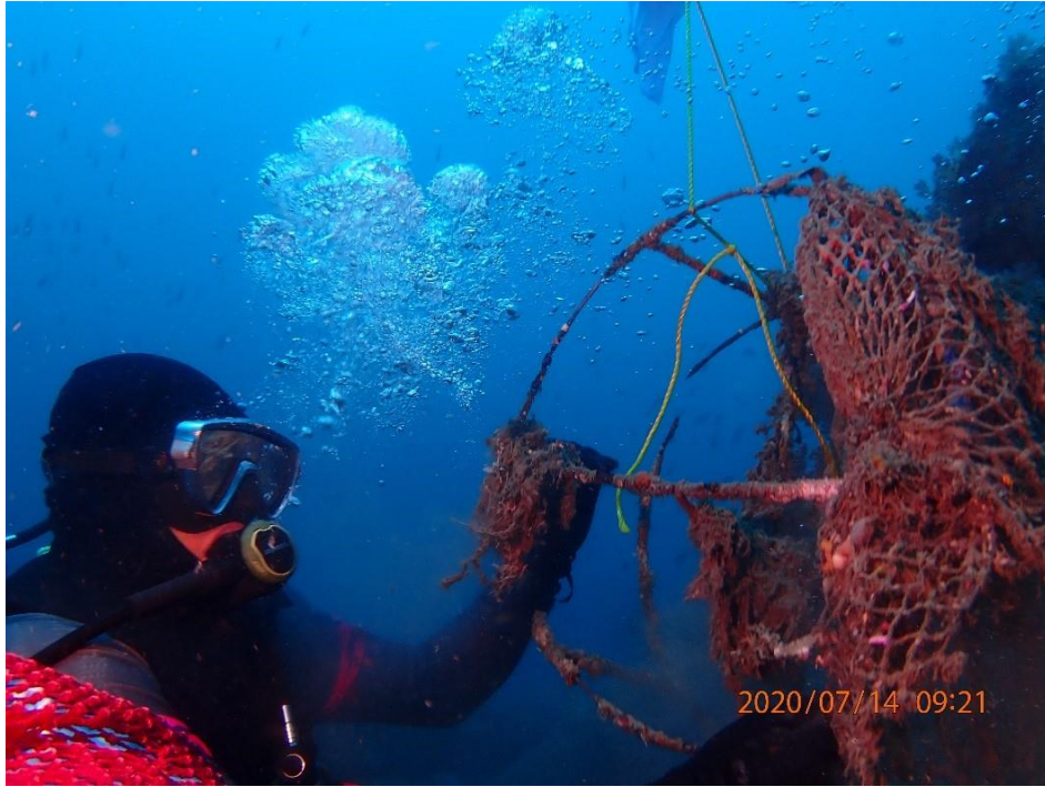
圖 9、礁區覆網清除-潛水員於水中進行覆網移除作業
