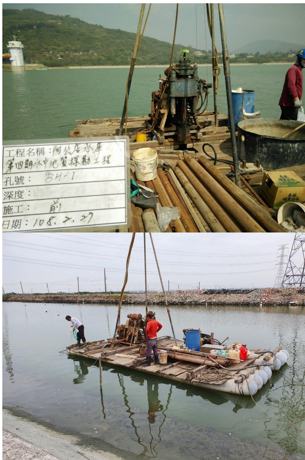
附圖四 鑽探用浮台尺寸：8m(長)×4.3m(寬)
