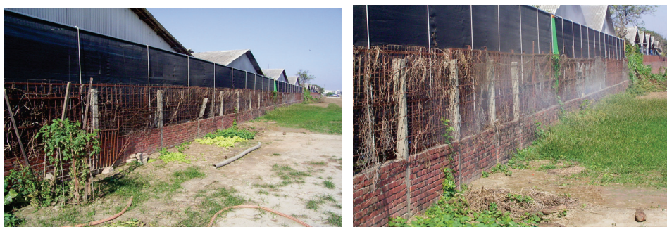
圖 1. 開放式養豬場空氣污染防治設施外觀
