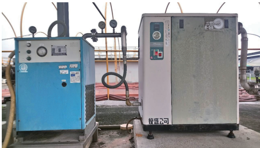
圖 1. 乳牛場廢水處理系統之沼氣發電前處理設備 (左：冷凍乾燥機；右：空壓機)。
