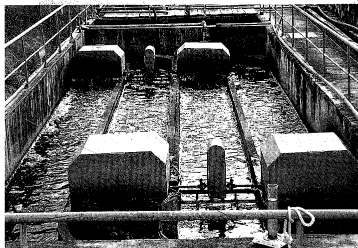
氧化溝與曝氣機車安裝位置。
