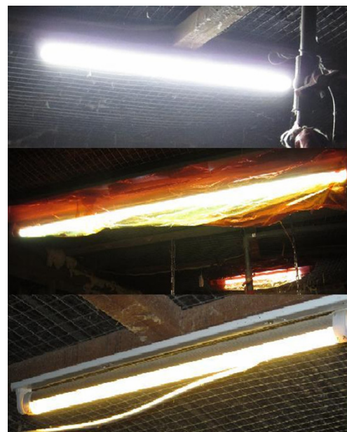
▲以發光二極體燈源 (正白光 LED、暖白光 LED) 取代傳統照明 (普通日光燈) 設備於雞蛋之生產，結果顯示，LED 燈源可節省 60% 之電力能源
