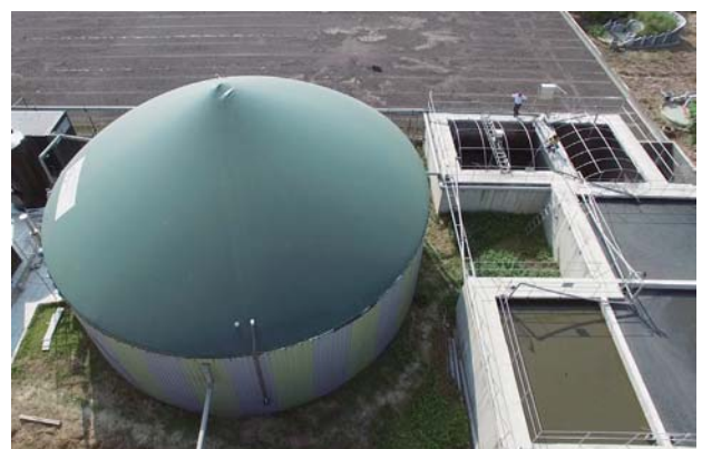
▲能源廠設之直立式發酵槽
