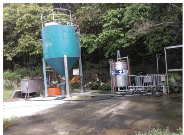
▲直立式厭氧槽自動控制進出水流程
