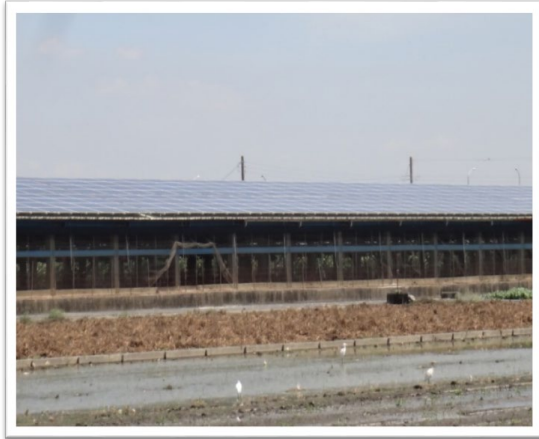
圖 7-5. 雞舍屋頂架設太陽能板圖。
