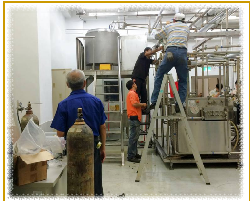
乳品加工設備遷移過程之管路定位 / 郭卿雲 攝影 105. 11. 21
