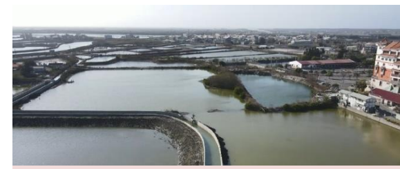
111年台南市南興七中排水治理工程
