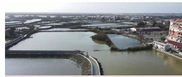
111年台南市南興七中排水治理工程
