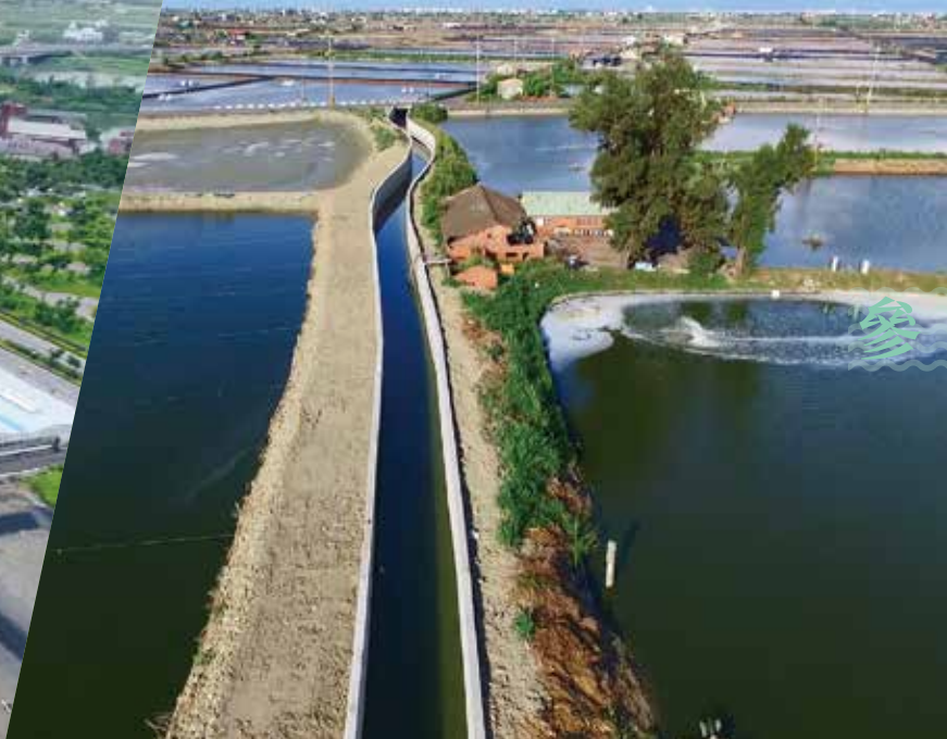
↑嘉義縣西新店養殖區二中排改善工程，整建排水路 913 公尺，增加養殖區淹水耐受力及保護面積 159 公頃
