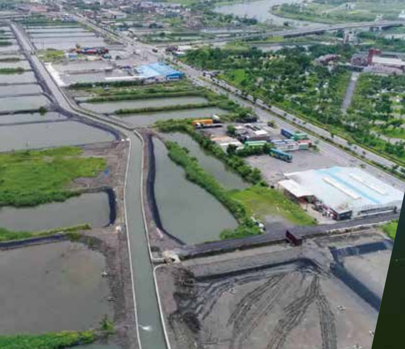
↑宜蘭縣新水養殖區清水排水改善工程，整建排水路 1,354 公尺，增加養殖區淹水耐受力及保護面積 220 公頃
